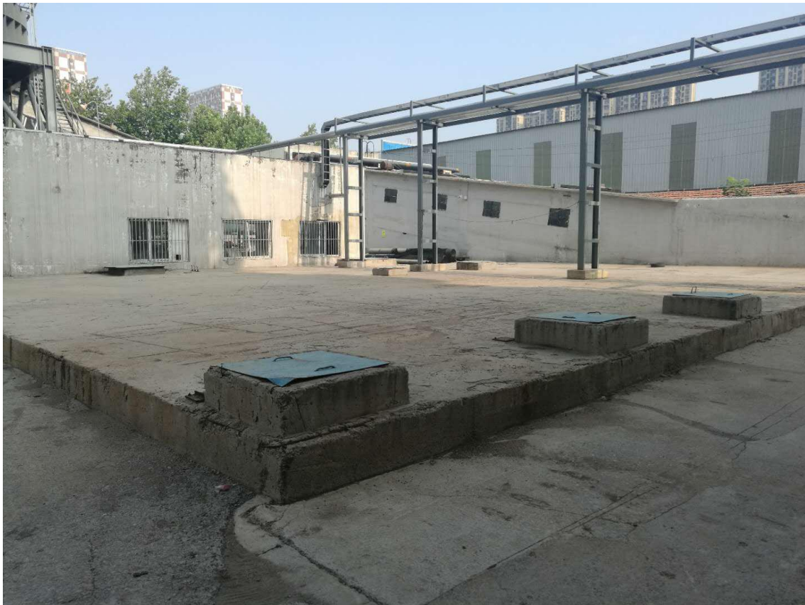
图 2-6 项目事故应急池
