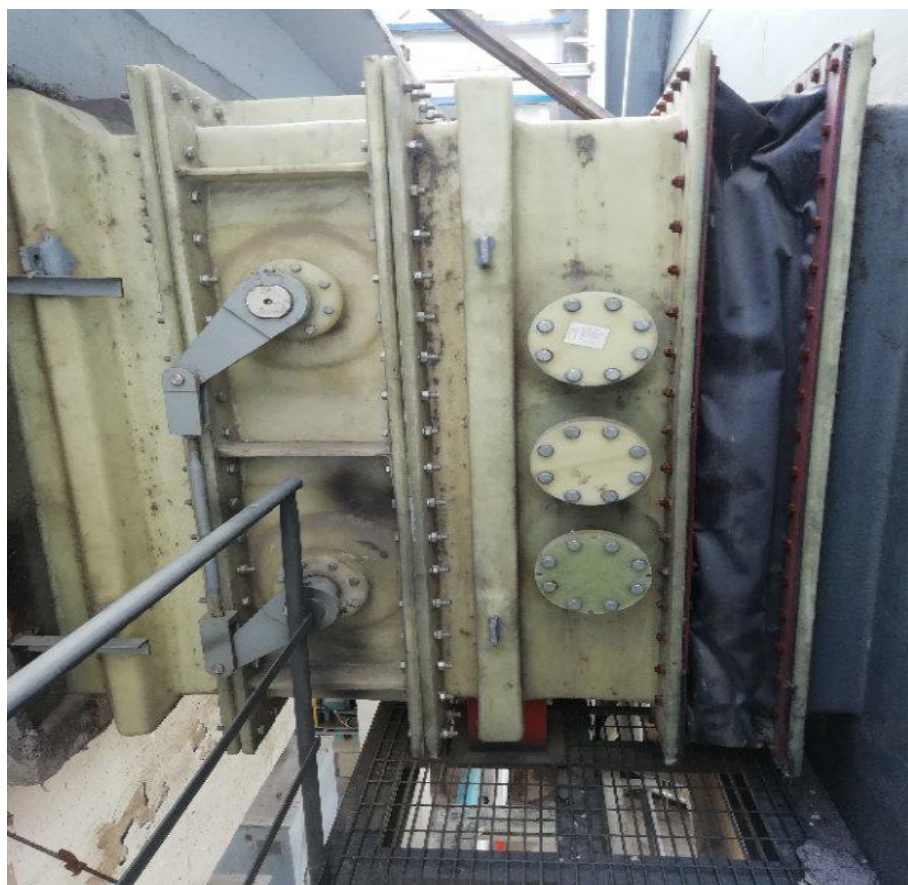
图 5-1 3#锅炉湿电除尘器后检测口
