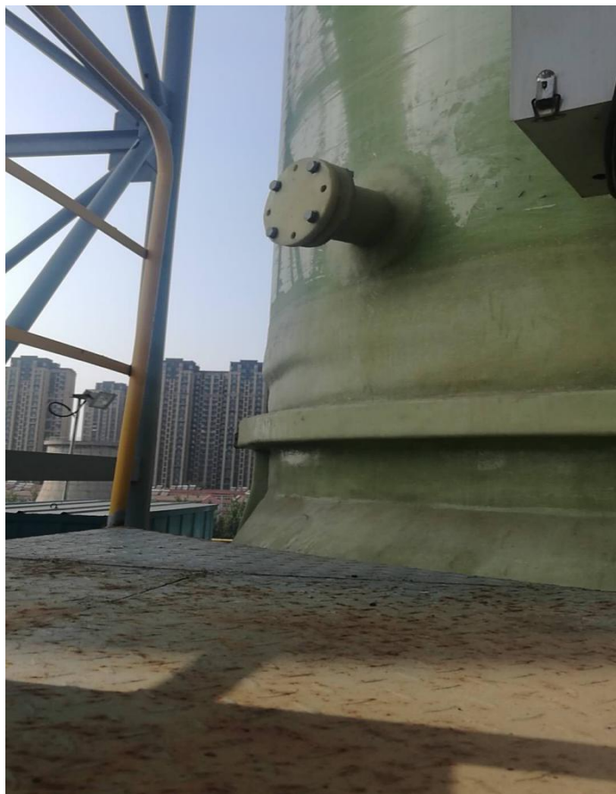
图 5-5 3#锅炉脱硫后、湿电除尘器前检测口
