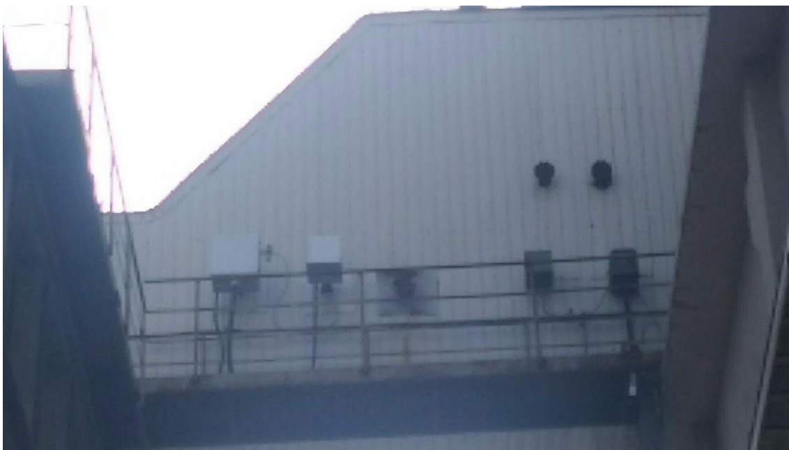
图 5-3 3#锅炉脱硫前检测口
