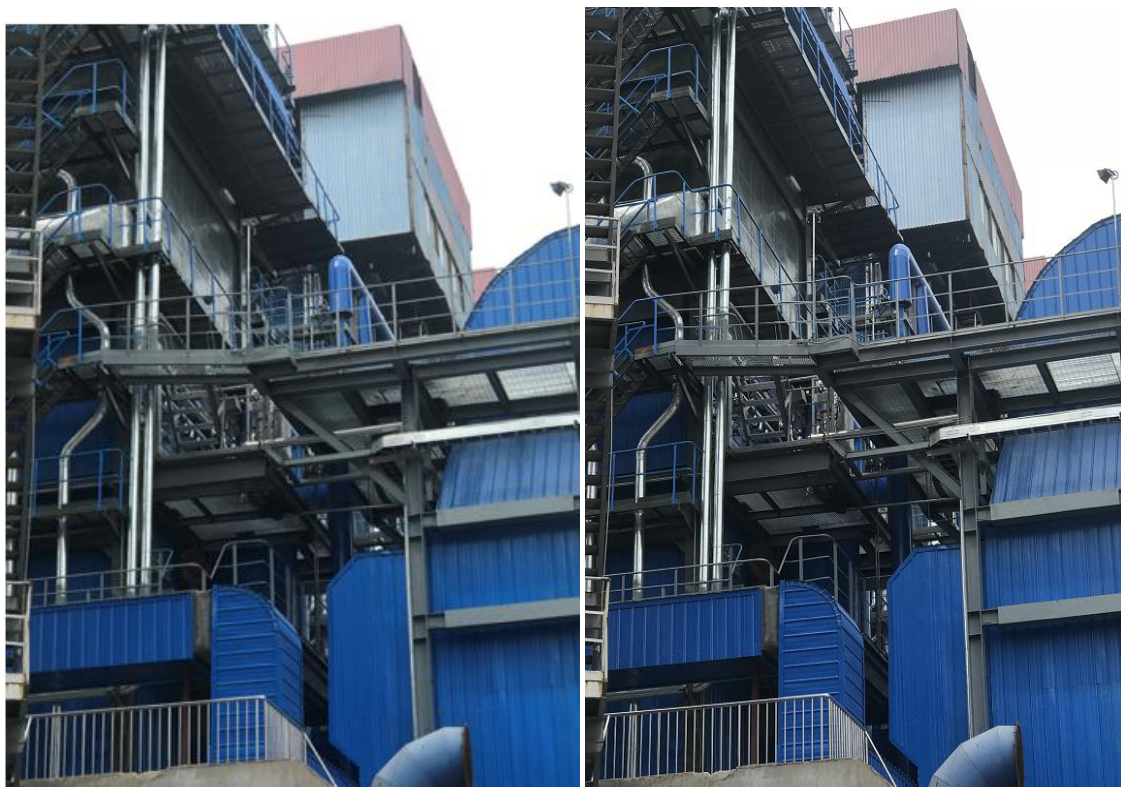
图 2-7 项目脱硝装置 (SNCR+SCR)
