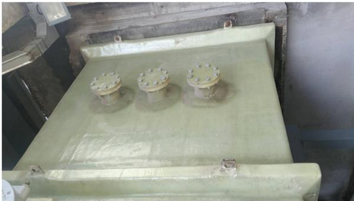
图 5-1 3#锅炉湿电除尘器后检测口
